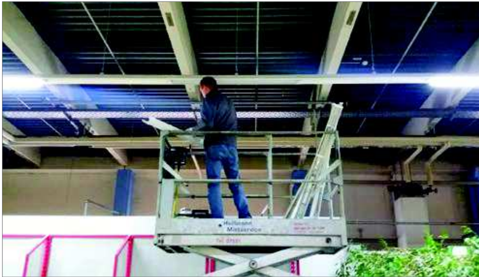
Montage der Beleuchtung im GildeCenter der Aufbaugilde in Heilbronn
