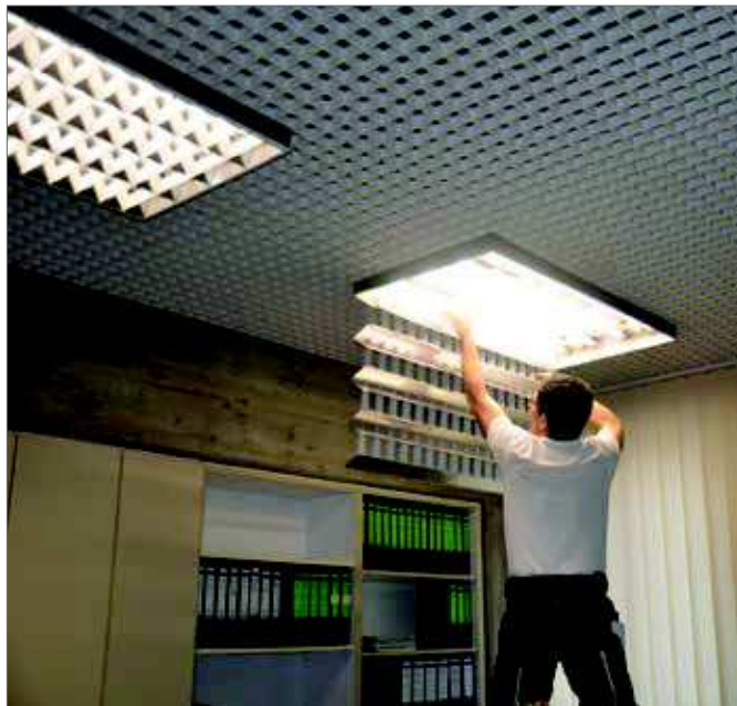
Montage der Beleuchtung im Verwaltungsgebäude der Stadt Leutkirch
